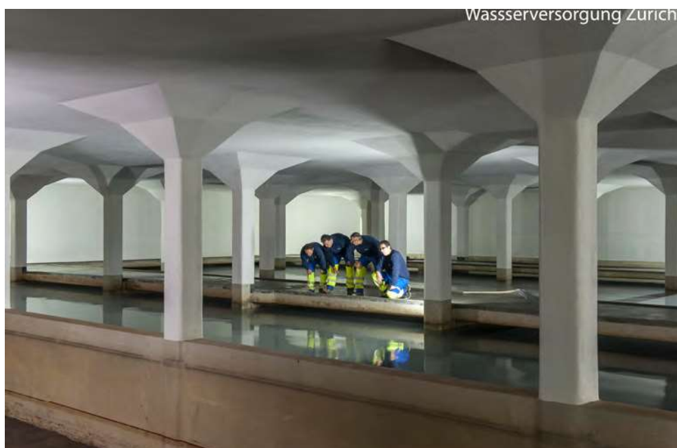
Zisterne der Wasserversorgung Zürich
